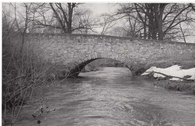
24/ Pozoruhodný most přes Smědou ve Vsi pochází z první poloviny 18. století. V roce 1996 byl rekonstruován, stav k r. 2010.
